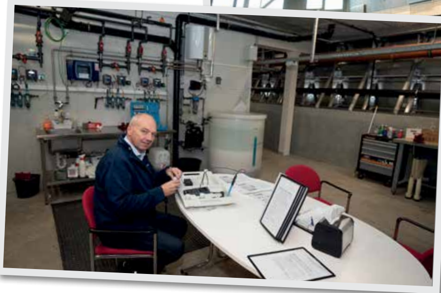
Driftschef Leif O. Pedersen i teknikrummet, som ligger i stueetagen. Th. ses stålbassinet.
