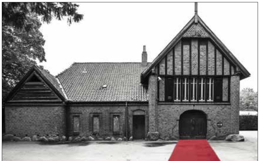
Taget er utæt og der mangler varme og isolering – så siden 2016 er Østre Kapel kun brugt til sommerteater. (Foto: Sydhavns Teater)
