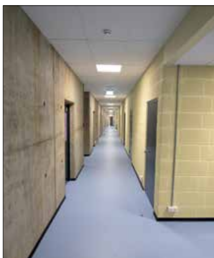
Rå beton og gule vægge i gangene, hvor der ligger de 14 omklædningsrum plus et hav af depotrum.
