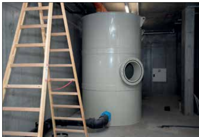
Denne tank skal holde vandet i det udendørs varmtvandsbassin varmt natten over.
