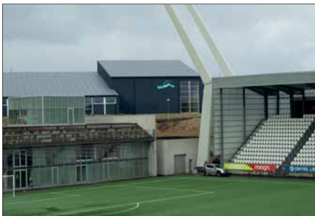
Svømmehallen med logoet med den blå bølge ligger lige op til fodboldstadion. Og fra det udendørs varmt- og koldtvandsbassin kan man se på en af fodboldbanerne.
