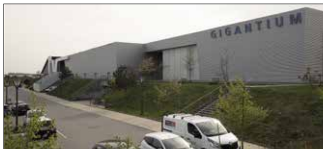
Gigantium på 42.000 m 2 er Danmarks største indendørs idrætsanlæg – men vej- og parkeringsforhold kigges der nu på, fordi vejen blev anlagt til en mindre hal med en kunstgræsbane.
