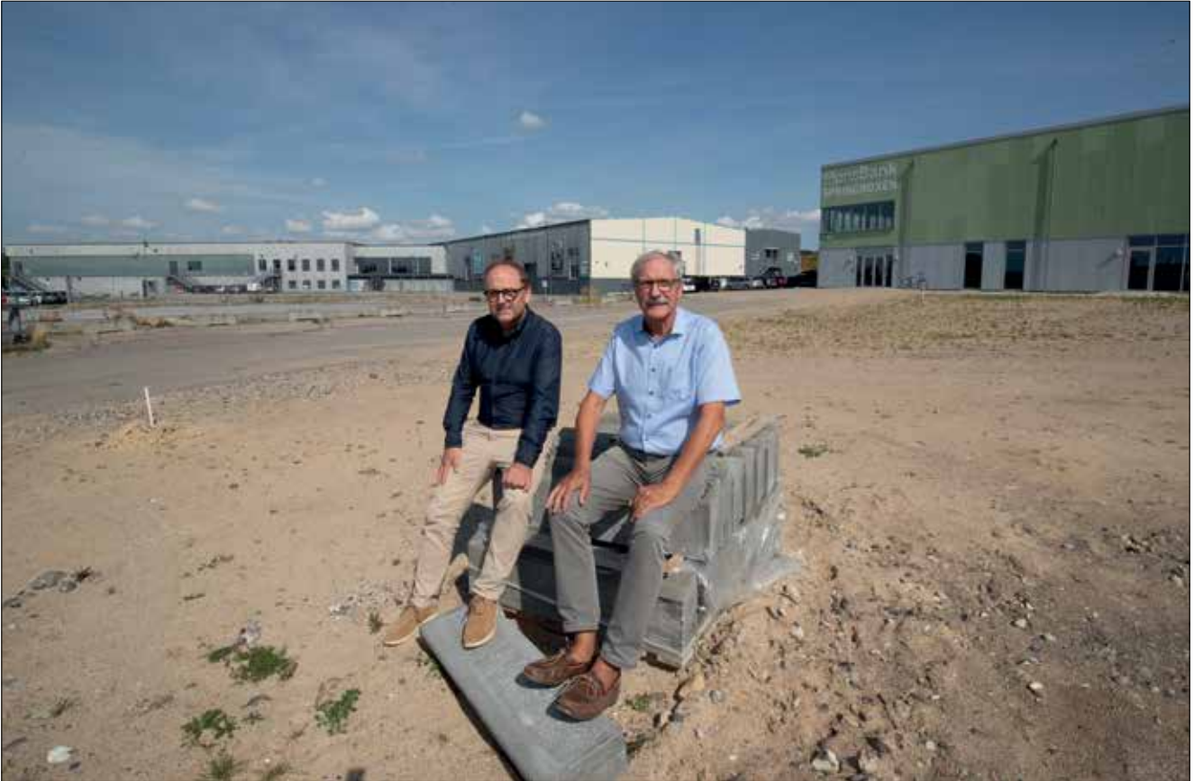
Direktør Hans Snekstrup og bestyrelsesformand Nels Petersen, DGI Huset Vordingborg. Bag dem th. skal padelhuset opføres. Fra venstre Vandhuset, arenaen og Spring- og Bevægelseshuset.
