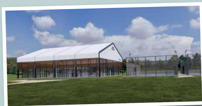
To af de udendørs padelbaner i Arena Aabenraa overdækkes. Overdækningen består af en stålkonstruktion på næsten ti meter i højden, som bliver dækket tagdug, som lader 90 % af lyset trænge gennem. (Foto: Norcover).
