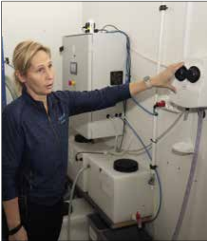
Karina Vedel Hansen i rengøringsrummet, hvor hun viser nano-anlægget: Et firma coater gulvene én gang om året, og så rengøres med en blanding af salt og vand. Det er en meget miljøvenlig og nem rengøring.
